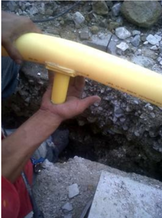
FIGURA 12 :INSTALACIÓN DE LA SILLETA EN LA TUBERÍA
