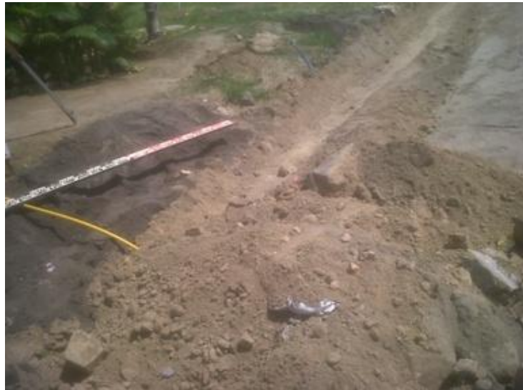
FIGURA 9: TUBERÍA ENTERRADA Y COMPACTADA
