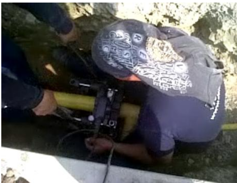
FIGURA 17 : CALENTAMIENTO DE AMBOS EXTREMOS DE LOS TUBOS CON LA PLANCHA
