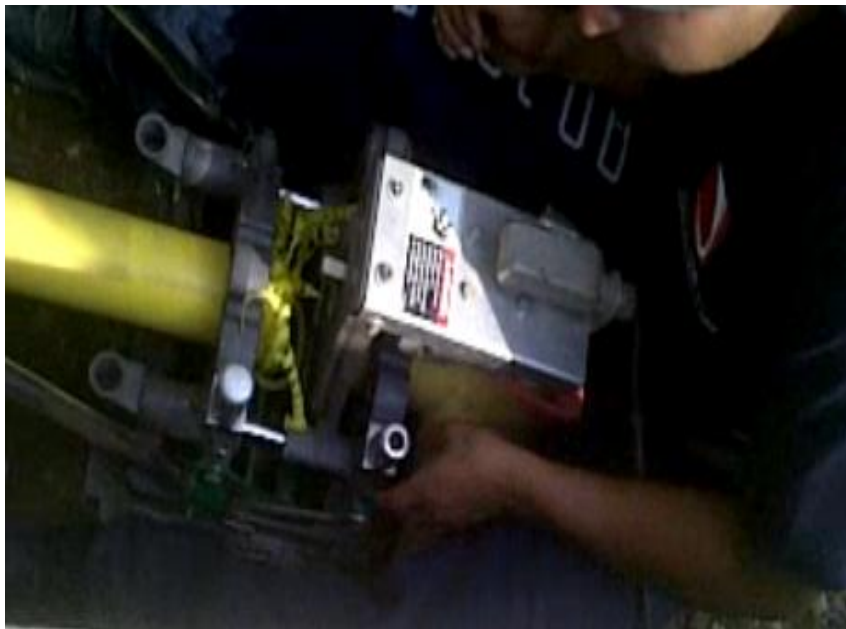
FIGURA 15 : REFRENTADO DE LA TUBERÍA DE POLIETILENO
