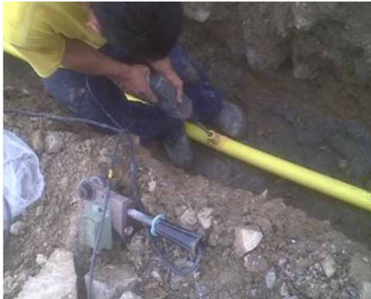
FIGURA 13: PERFORACIÓN DE ORIFICIO PARA ACOMETIDA
