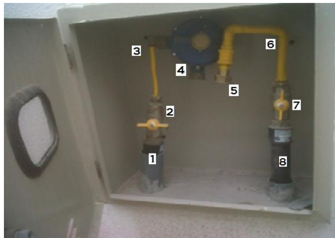
FIGURA 25: TREN DE REGULACIÓN DE SEGUNDA ETAPA
