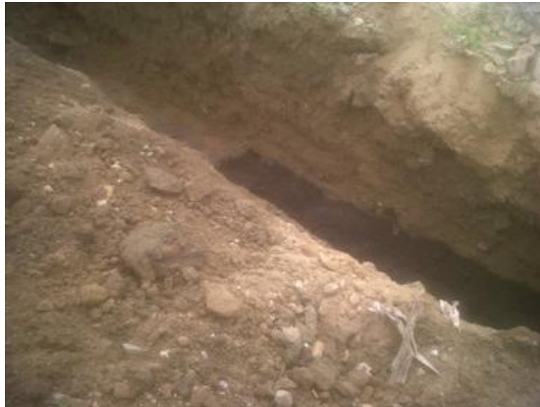
FIGURA 7: PRIMERA CAPA BASE DE ARENA DE 10 cm. DE ESPESOR
