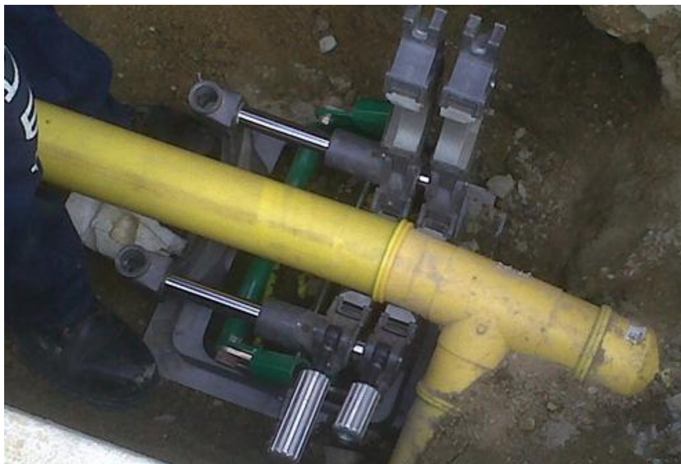
FIGURA 18 : INSPECCIÓN DE LA UNIÓN POR TERMOFUSIÓN A TOPE
