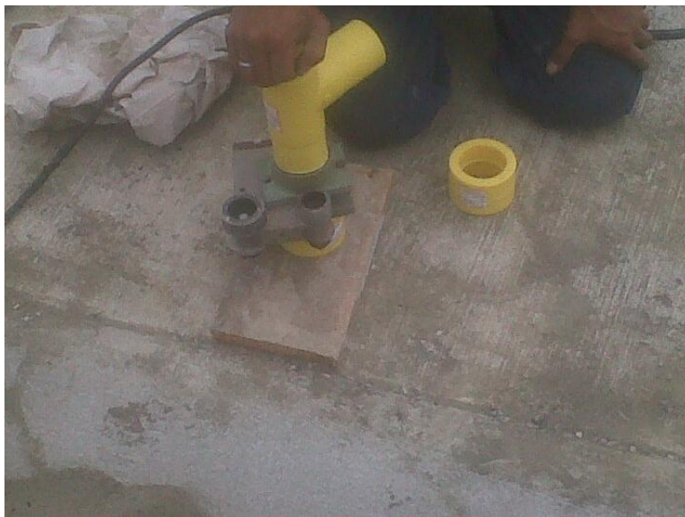
FIGURA 19: CALENTAMIENTO DE ACCESORIOS CON SOCKET
