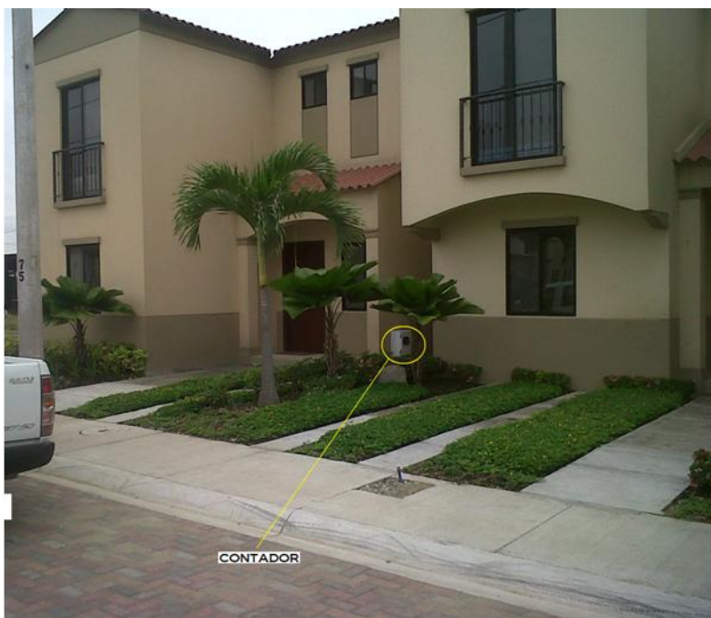
FIGURA 23: UBICACIÓN DEL CONTADOR EN UNA CASA MODELO
