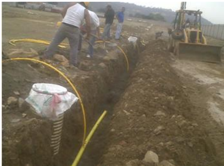
FIGURA 8: APLICACIÓN DE SEGUNDA CAPA DE ARENA DE 20 cm.
