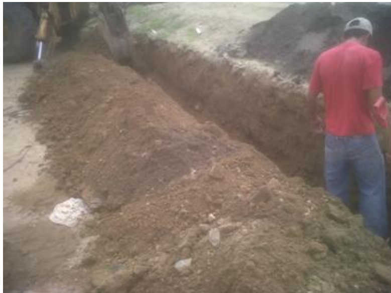
FIGURA 6:EXCAVACIÓN DE LA ZANJA
