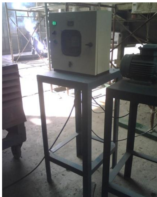
FIG. 2.20 FOTOGRAFÍA DE LA ESTRUCTURA DE SOPORTE TERMINADA
