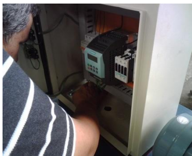
FIG. 2.25 FOTOGRAFÍA DEL MONTAJE DEL TABLERO DE CONTROL
