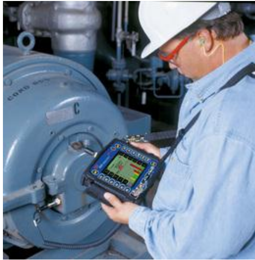
Figura 2.4 Toma de datos con transductor.
