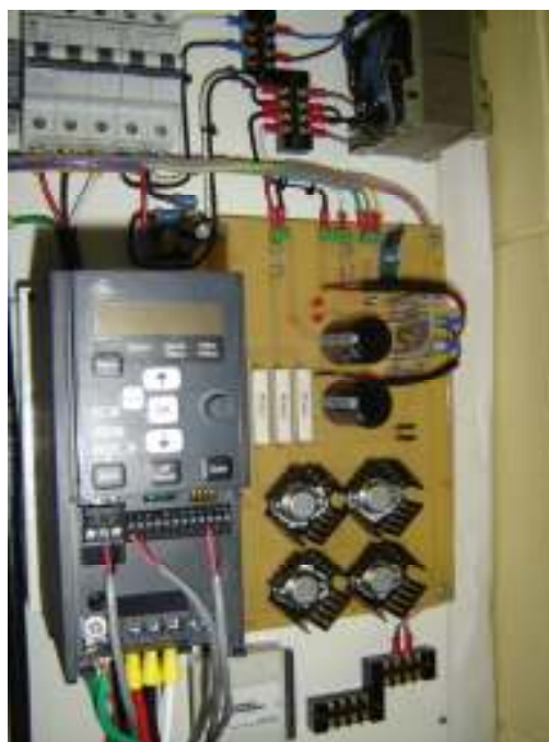
Figura 27. Montaje de Tarjetas
