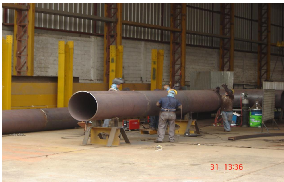
Figura 1.1.15 Soldado de tubos
