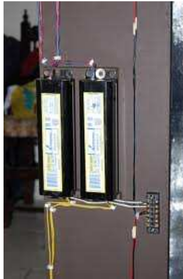
Figura 2.7 Balastro magnético (carga que produce armónicos)
