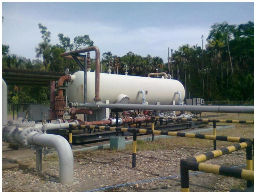
**Figura 3-14:** Separador de Prueba del Well Pad Fanny 20.
