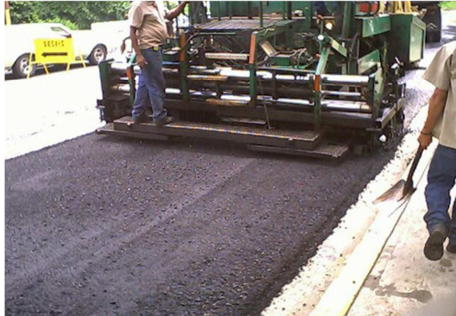
Figura 6-5.- Colocación de hormigón asfáltico como capa de rodadura
