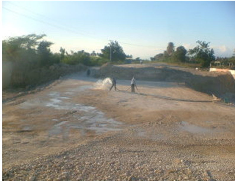
Figura 6-9.- Terreno rellenado con material de común
