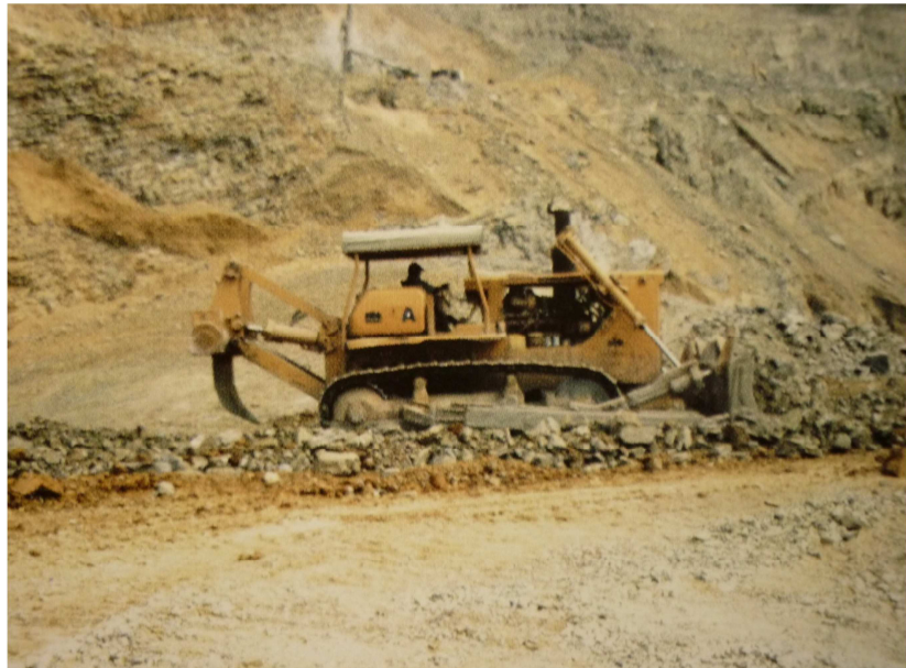
Figura 3-2.- Bulldozer realizando la extracción por arranque mecánico
