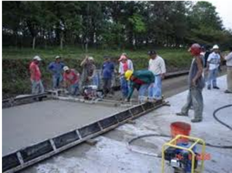
Figura 6-7.- Colocación de Hormigón Hidráulico
