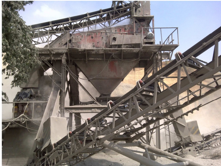
Figura 4-5.- Zaranda Vibratoria de la cantera San Luis
