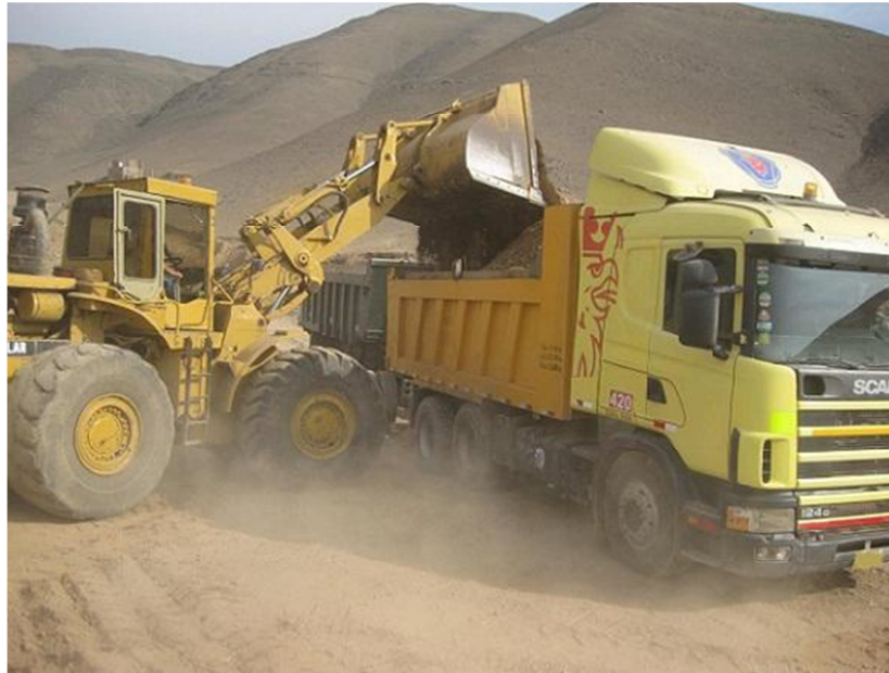
Figura 6-10.- Material de cantera para relleno
