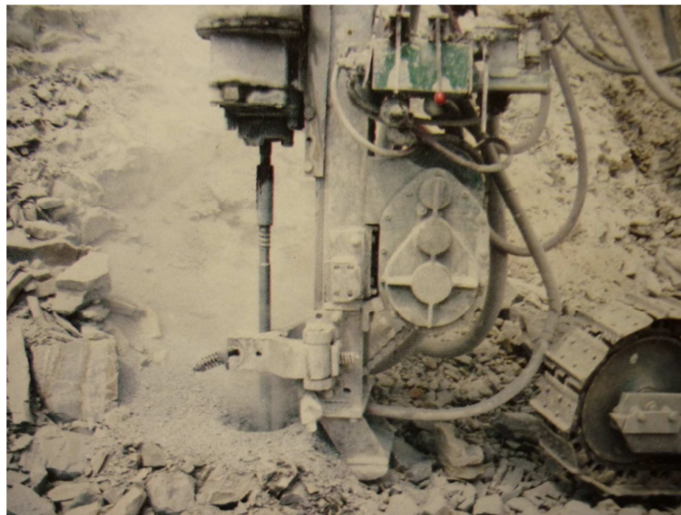
Figura 3-4.- Proceso de perforación de ejes de acero en macizo rocoso
