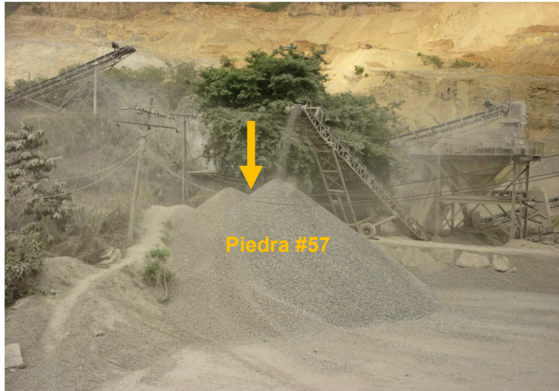
Figura 4-7.- Almacenamiento de la Piedra #57
