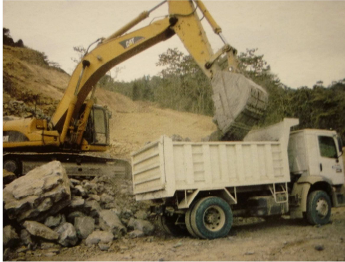
Figura 3-9.- Excavadora CATERPILLAR 320 C sobre oruga para carga de agregados a volquetas para la posterior trituración
