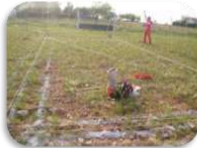
Gráfico 41: Replanteo del terreno
