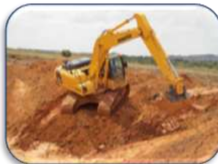
Gráfico 43: Excavación del terreno
