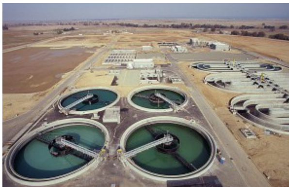
Figura 18.- Planta de tratamiento de aguas residuales
