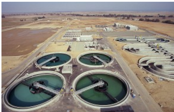
Figura 18.- Planta de tratamiento de aguas residuales
