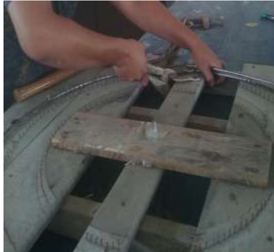
Figura XV. Moldeado de las varillas de hierro
