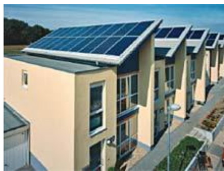
Figura 31.- Instalación solar integrada en tejadas de viviendas
