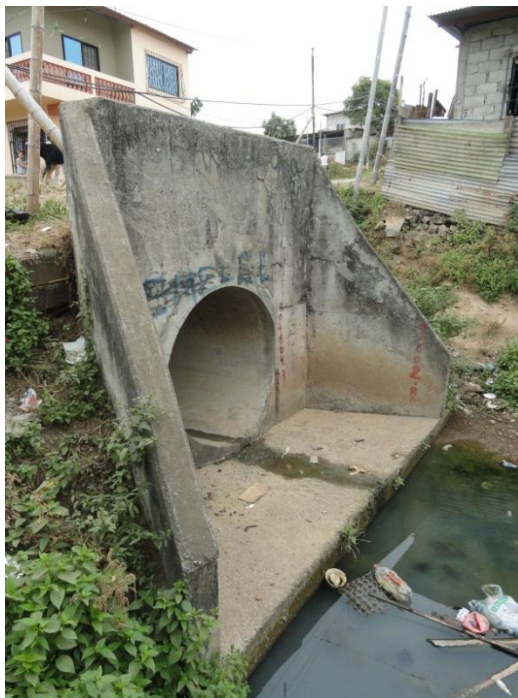
FOTO D.4 Alcantarilla existente de \varnothing=1.40 m en intersección de Calle 5N y Av. 25N
