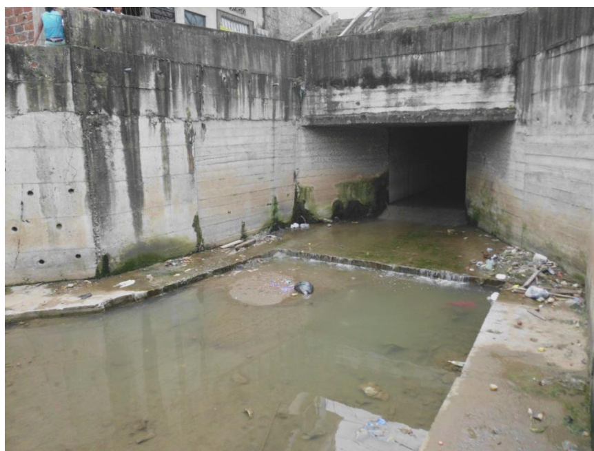
FOTO D.10 Ducto cajón que cruza la Modesto Luque
