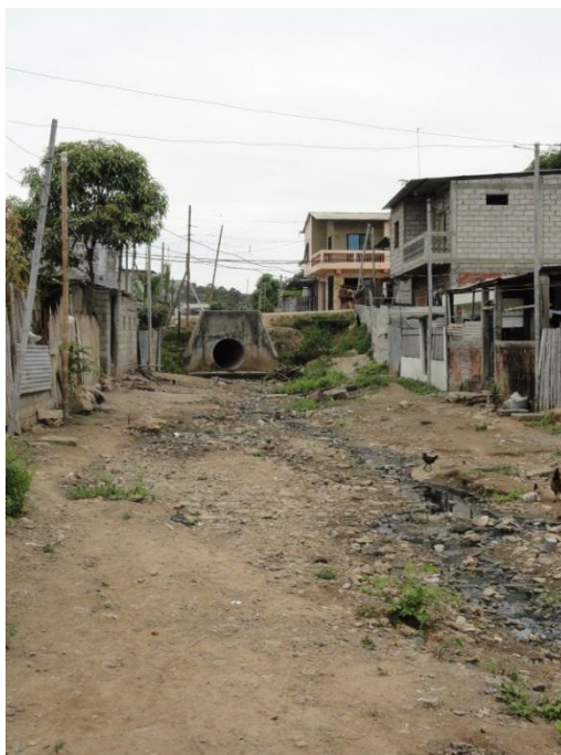
FOTO D.5 El caudal que cruza por la alcantarilla, escurre por superficie de Av. 25N
