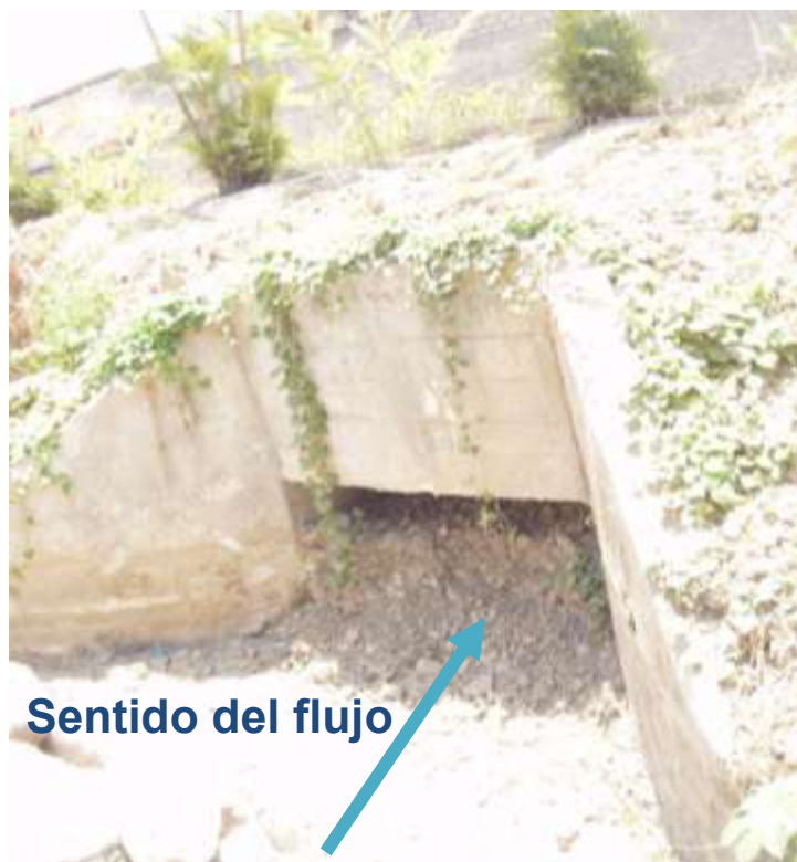
Foto 4.2 Ducto cajón – Ciudadela “Cumbres del Sol”
