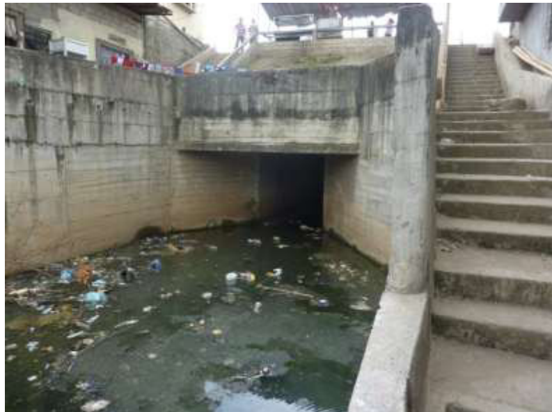
Foto 4.3 Ducto cajón que cruza la Calle Modesto Luque
