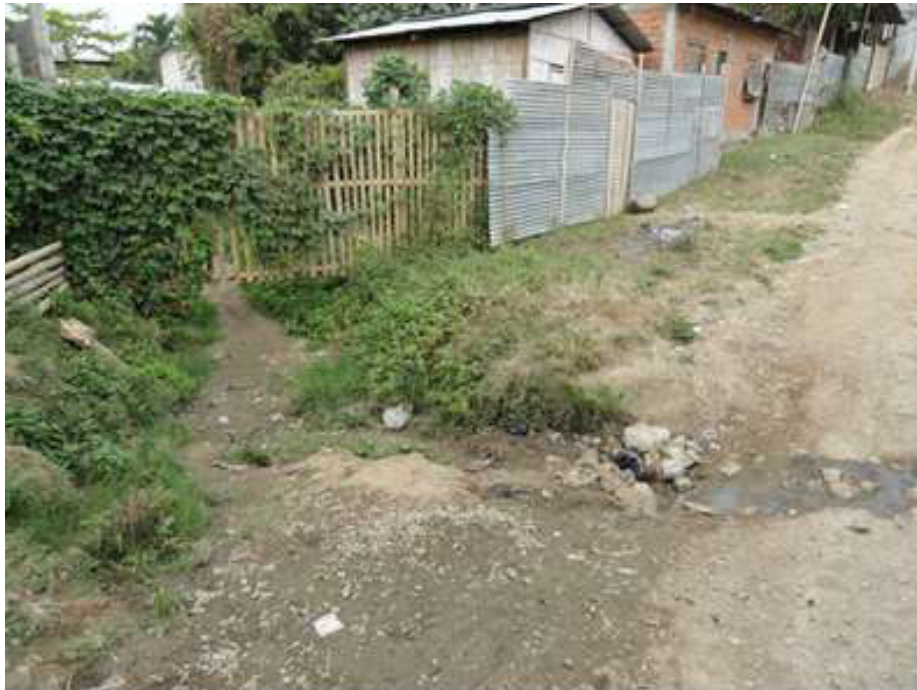
FOTO 1.1 Cauce que proviene de la Mz. 424 e ingresa a la Mz. 425, atravesando la Avenida 27 Norte
