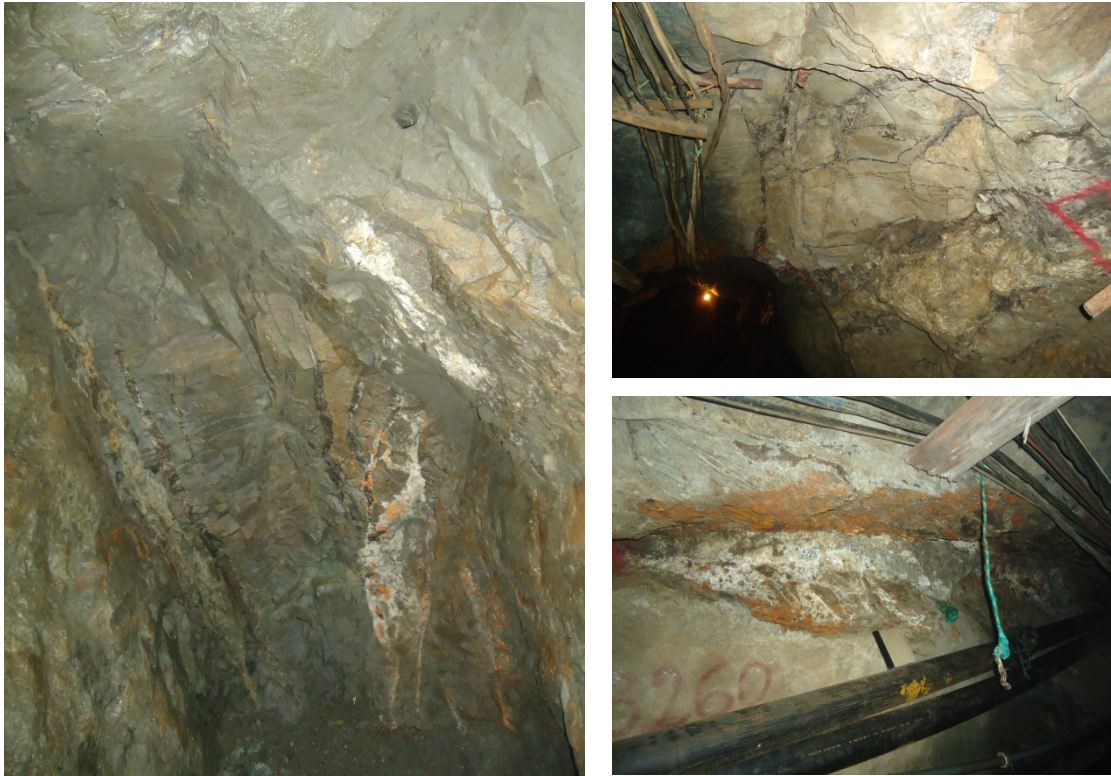
Fig. 16. Mineralogía característica de veta "Paraíso" en diferentes niveles de mina. (Fuente: Autor).
