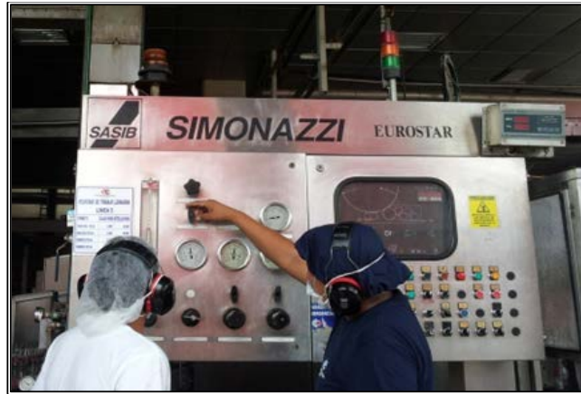
Fig. 7 Explicación de funcionamiento manómetros llenadora 5
