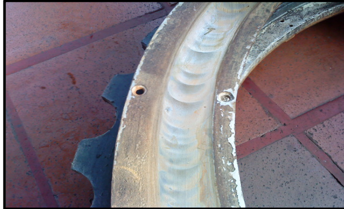
Fig. 12 Guía de deslizamiento desgastada
