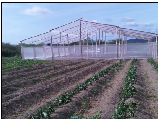
FIGURA 4.11 INVERNADERO CONSTRUÍDO POR LA ESPOL EN LA COMUNA CEREZAL DE BELLAVISTA
