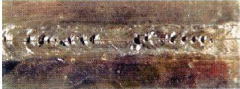
FIGURA 4.10.- POROS ALINEADOS UNIDOS POR UNA FISURA
