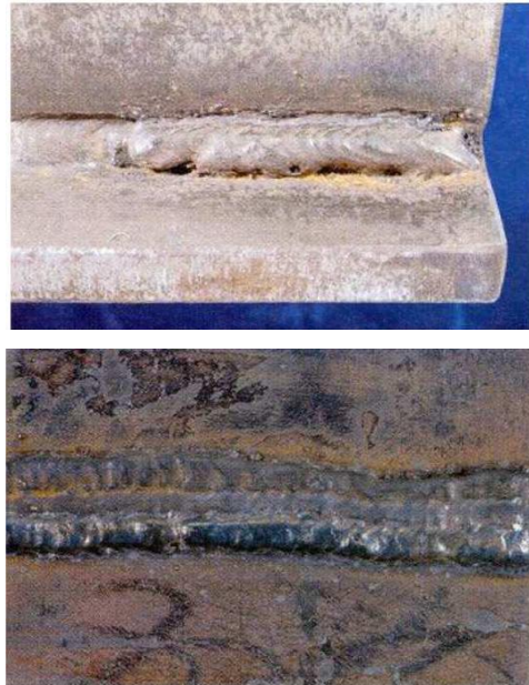
FIGURA 4.15.- SOLAPADO EN SOLDADURA DE FILETE Y CON BISEL
