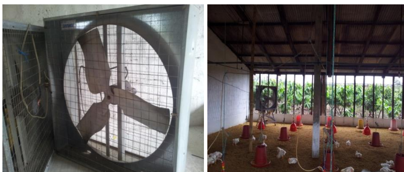
FIGURA 3.6. Instalaciones – Ventiladores Granja Avícola
