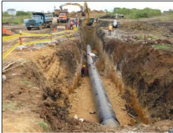
FIG. 1.1. INSTALACIÓN DE TUBERÍAS
