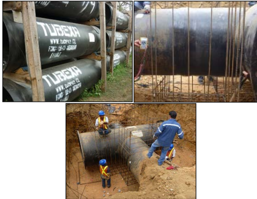
FIG. 3.1. INSTALACIÓN DEL ACUEDUCTO
