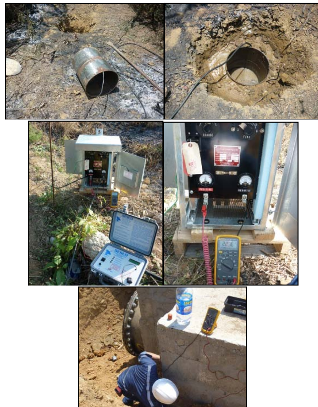
FIG. 3.2. PRUEBA DE CONDUCTANCIA ELÉCTRICA DEL RECUBRIMIENTO
