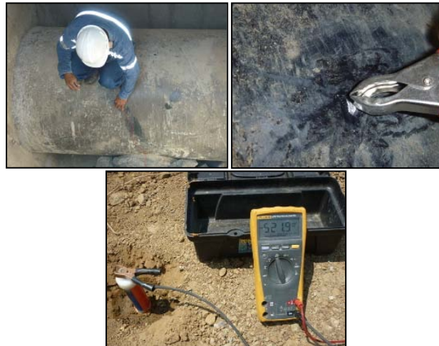
FIG. 3.5. MEDICIÓN DE POTENCIALES ELÉCTRICOS
