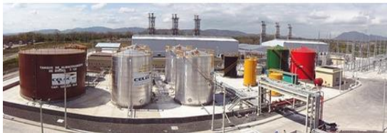
Figura 2.1. Vista panorámica de la central termoeléctrica Jaramijó
