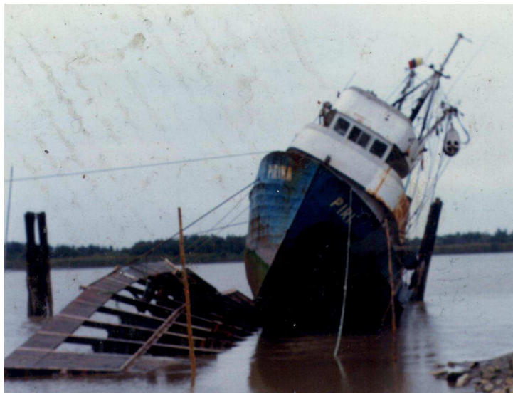
Figura N°11: Daño de la plataforma de varado.
