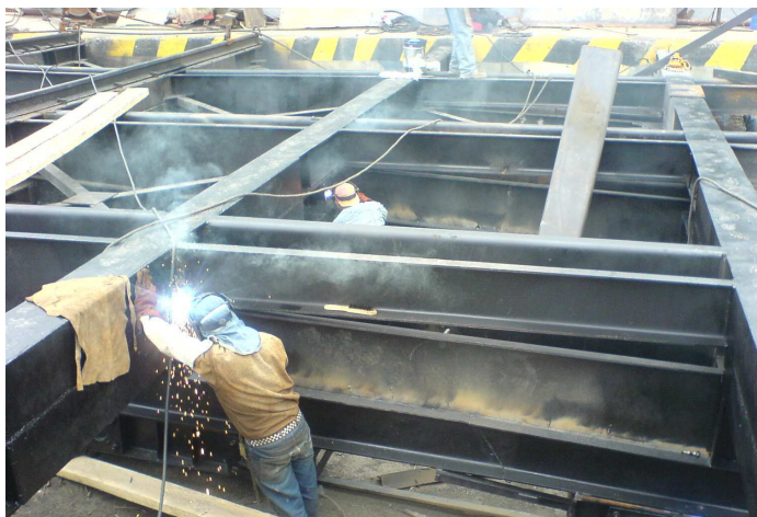
Figura N°22: Modificación de Estructura para montaje de brazos hidráulicos.
