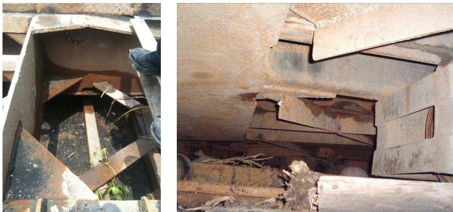
Figura N°26: Estructura de amarre adicionada (crucetas).
