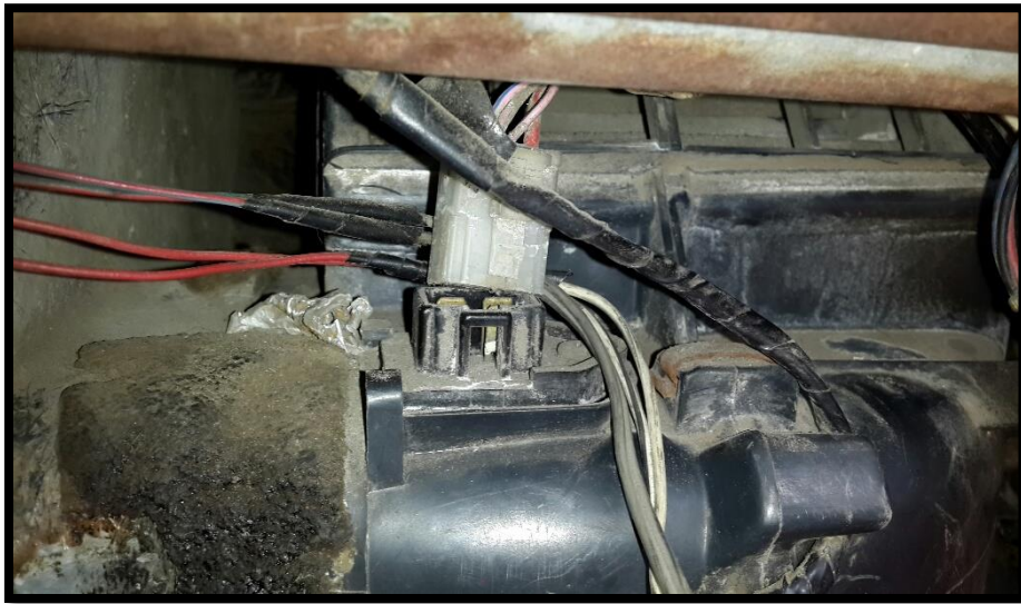
Fig. 5.10 INSPECCION DEL TABLERO, EVAPORADOR, ELECTROVENTILADOR
