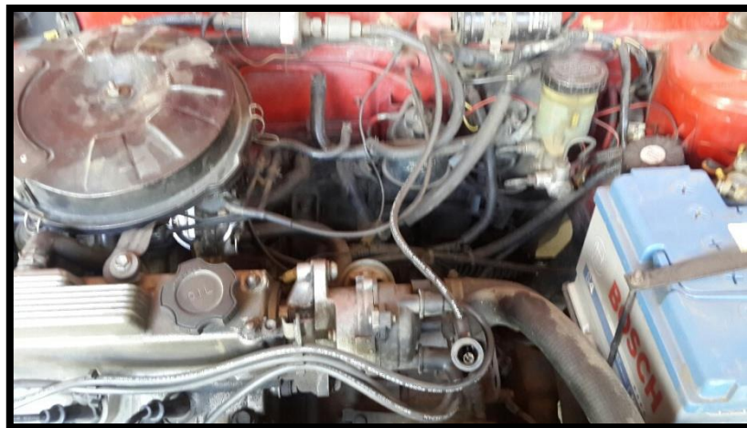
Fig. 5.9 INSPECCION DE MOTOR, CALEFACCION Y TUBERIAS DE ENFRIAMIENTO
