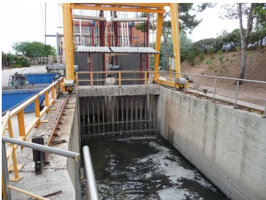
Figura 6. Rejas y tamices en acción (EMSHI, 2014)
