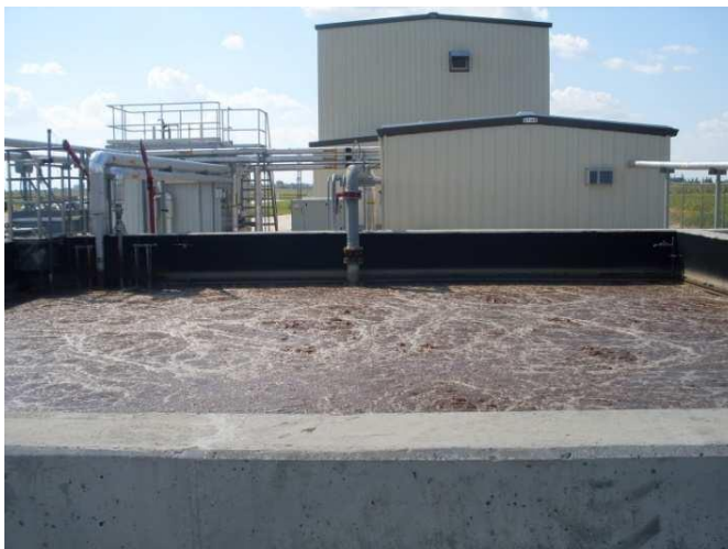
Figura 7. Ejemplo de tanque de preaeración (ADI, 2014)
