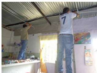
Figura 12. Trabajos eléctricos por parte de los estudiantes en una de las viviendas.
