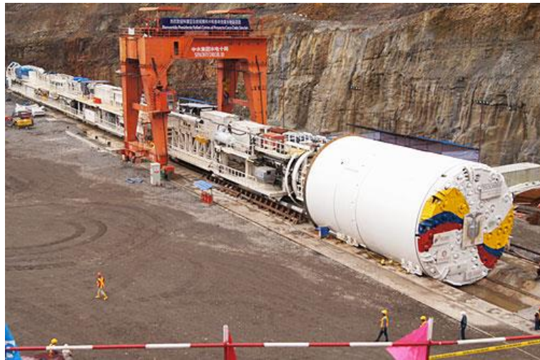
FIGURA 2.7. TUNELADORA EMPLEADA EN EL PROYECTO HIDROELÉCTRICO COCA - CODO SINCLAIR
