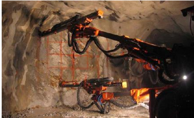
FIGURA 2.8. PERFORACIÓN Y VOLADURA DE UN TÚNEL
