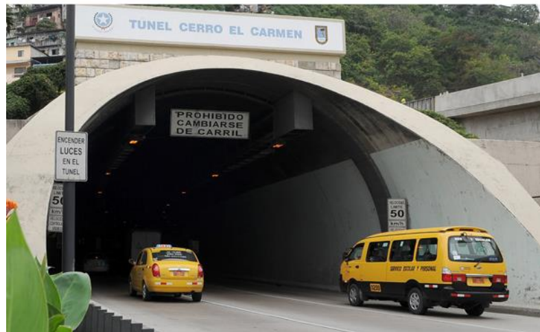
FIGURA 2.1. TÚNEL CERRO EL CARMEN (GUAYAQUIL)
