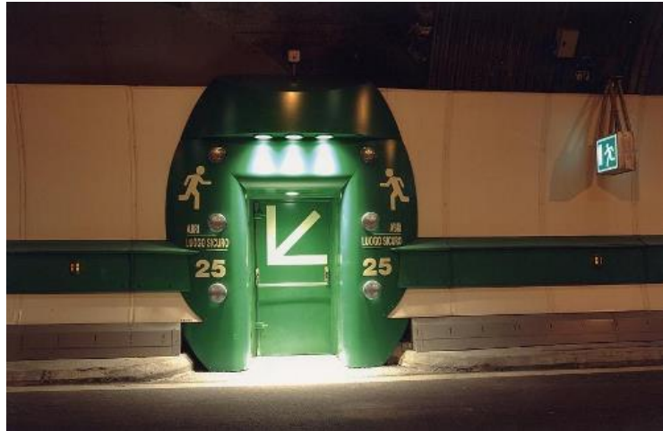
FIGURA 2.15. SALIDA DE EMERGENCIA
