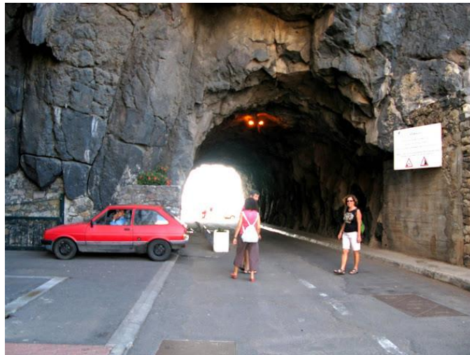
FIGURA 2.3. TÚNEL SIN REVESTIR
