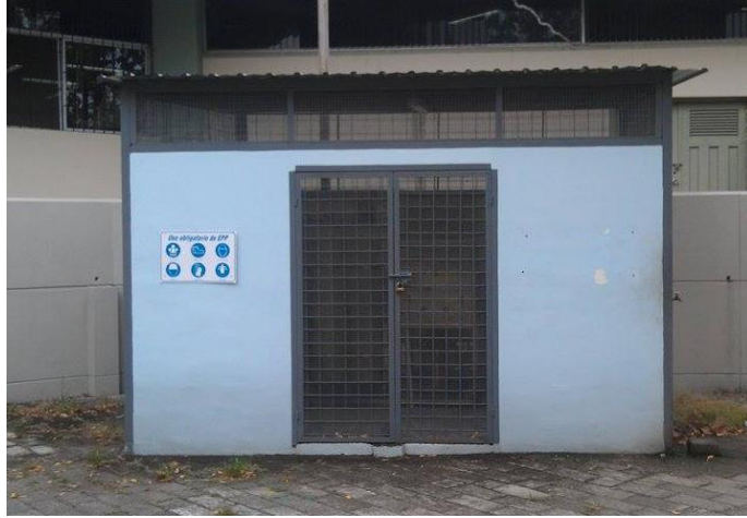
Figura 1.4. Vista frontal de la infraestructura actual
