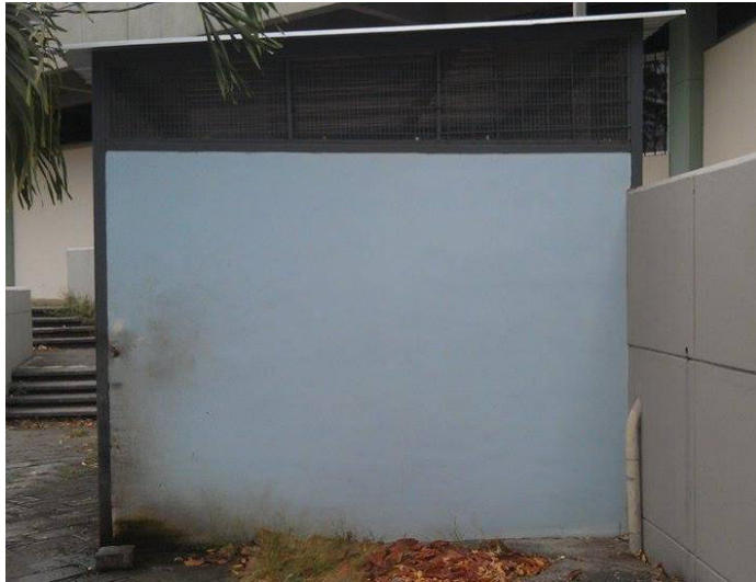
Figura 1.5. Vista lateral de la infraestructura actual
