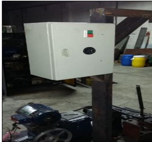
Figura 3.18. Instalación del panel de control en la estructura
