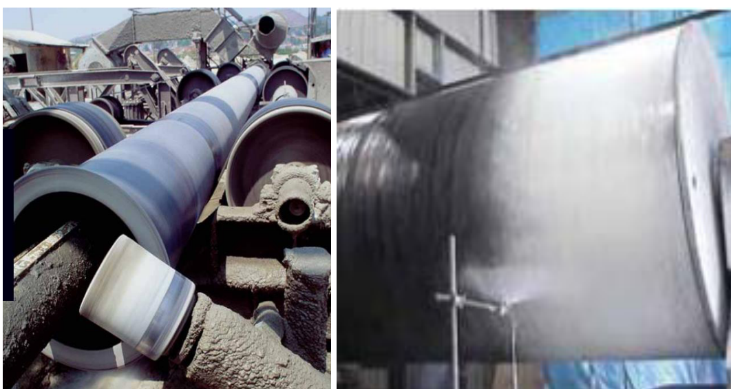
Figura 7. (Izq) Revestimiento de tubería aplicación de mortero de forma centrifuga. (Der) Aplicación de Pintura blanca sobre esmalte de Alquitran de Hulla.
