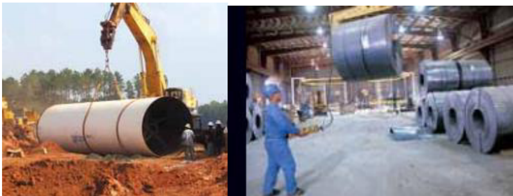
Figura 6. (Izq) Tubería de 120 pulgadas para agua cruda. (Der) Rollo de 20 Ton para la fabricación de tubo.
