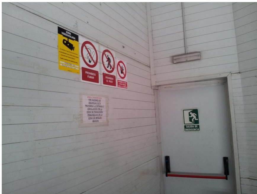
FIGURA 3.5 PUERTA DE RECEPCIÓN CERRADA
