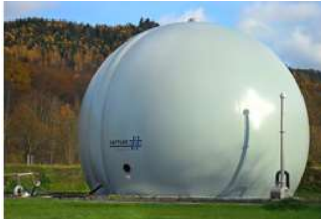
FIGURA 3.24 GASÓMETRO DE DOBLE MEMBRANA
