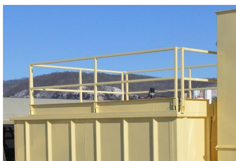
FIGURA 4. 3 DISEÑO E INSTALACIÓN DE BARANDAS DE SEGURIDAD
