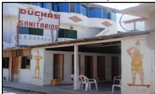
Foto JPG No. 25 Área de duchas y sanitarios para bañistas
