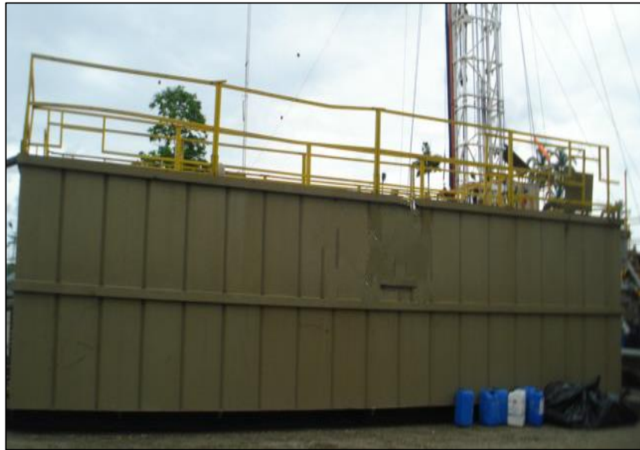
Figura 2.6: Tanque de Agua a filtrarse para el uso del control de pozo con capacidad de 500 barriles.
