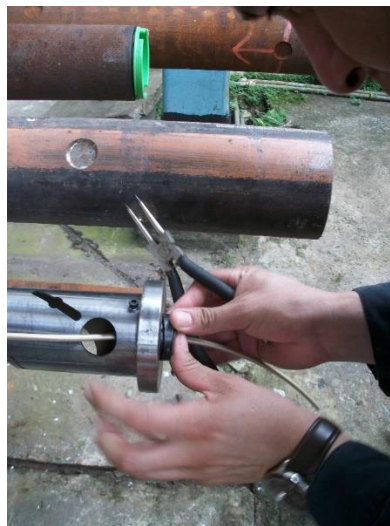
Figura 1.28 Colocación Del Centralizador
