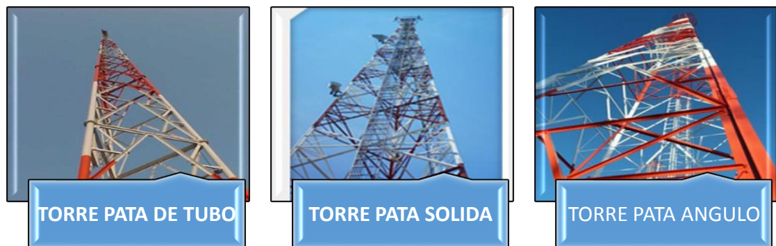
FIGURA 1.5 TIPO DE TORRES AUTOSOPORTADAS. [19]
