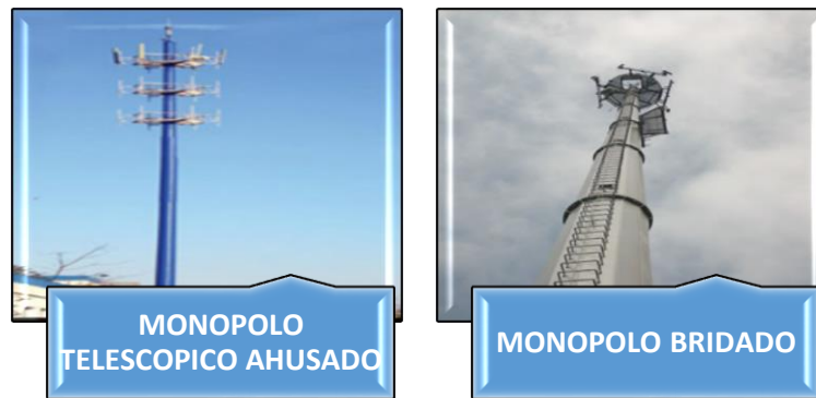
FIGURA 1.6 TIPOS DE MONOPOLOS. [20]
