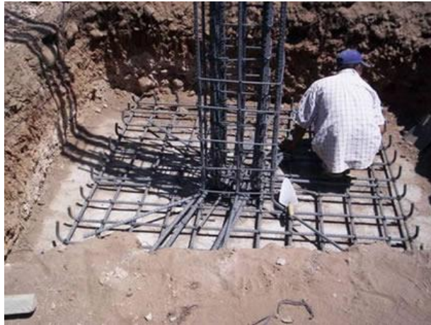
FIGURA 1.7 CIMENTACIÓN TORRE AUTOSOPORTADA. [21]
