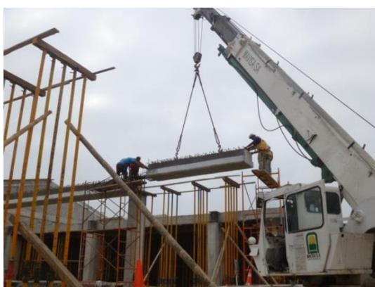
Gráfico 32. Izaje de vigas presforzadas para sistema estructural de planta alta de los bloques 2 y 4. (Foto tomada del informe fotográfico de Etinar del 10 al 22 de junio del 2013)
