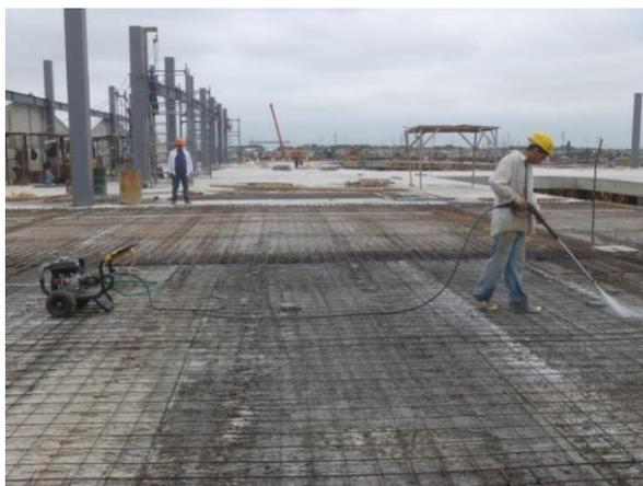
**Gráfico 34.** Mallas electrosoldadas y limpieza antes de fundición con hormigón premezclado para losas de compresión de los bloques 2 y 4. (Foto tomada del informe fotográfico de Etinar de Agosto del 2013)
