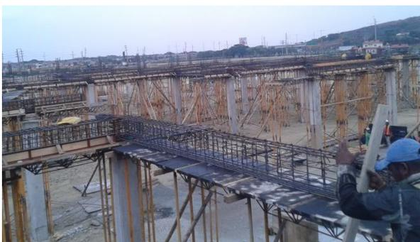
Gráfico 35. Procedimiento constructivo para vigas cargadoras y de amarre del bloque 3 (Foto tomada del informe fotográfico de Etinar del 10 al 22 de junio del 2013)
