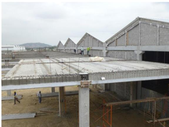
**Gráfico 33** Vigas doble t que formaron parte del sistema estructural de la losa de compresión de los bloques 2 y 4. (Foto tomada del informe fotográfico de Etinar del 10 al 22 de junio del 2013)
