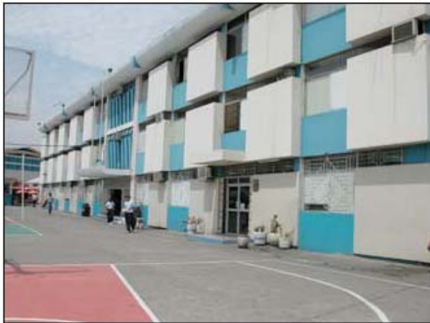
Foto 3.1 Edificios de Aulas
