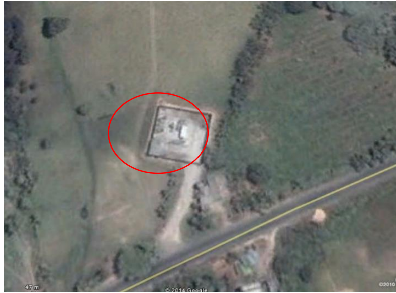
Figura 1.2 Vista Satelital – Subestación Juan Bautista A.
