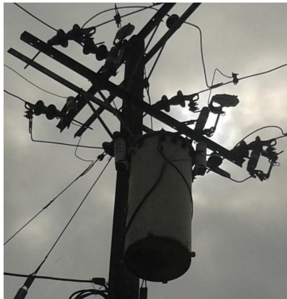
Figura 1.11 Transformador Auxiliar
