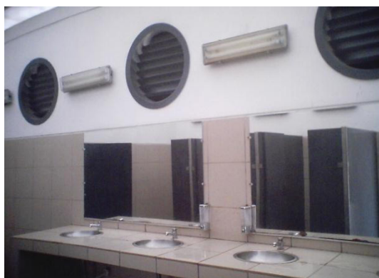
Foto JPG 6 Vista de lavamanos de baños de hombres
