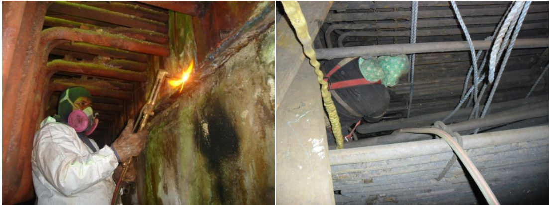
FIGURA 5.8 CORTE DE TUBERÍA CON PROCESO OXIACETILÉNICO.
