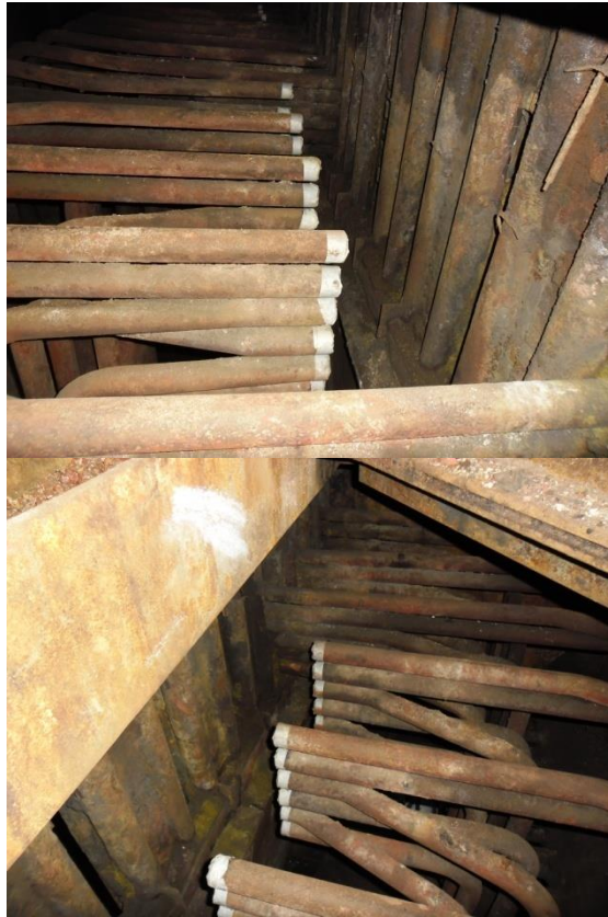
FIGURA 5.11 BISELADO DE TUBERÍA.
