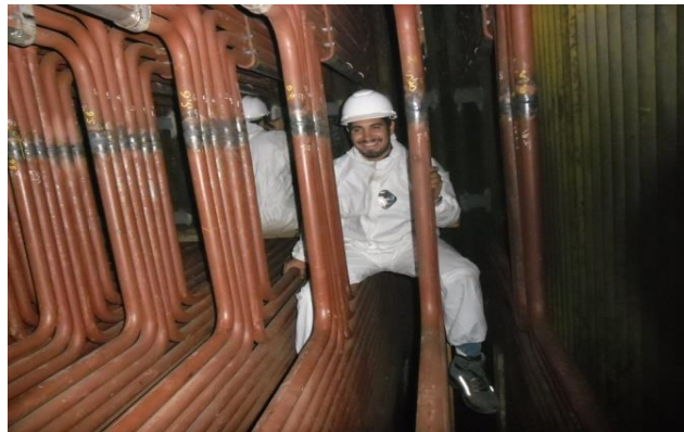
FIGURA 5.20. INSPECCIÓN DE JUNTAS SOLDADAS
