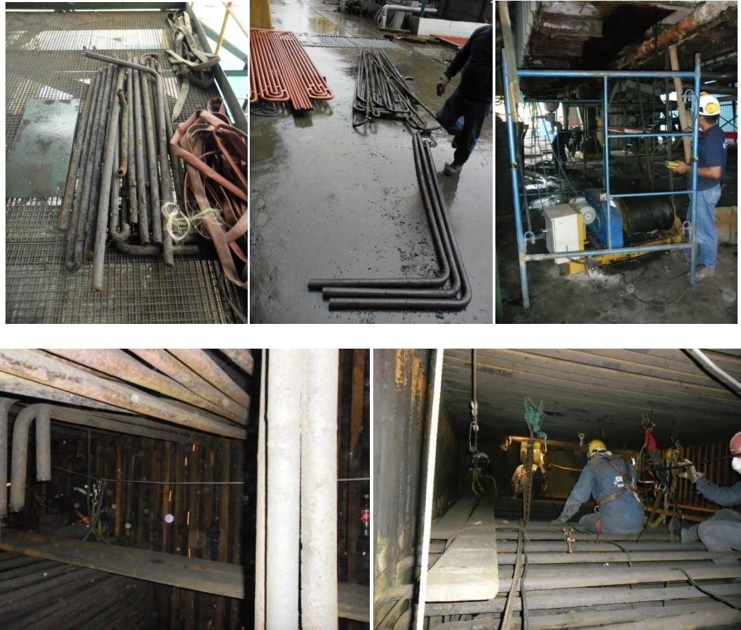
FIGURA 5.10 DESMONTAJE DE SECCIONES DE SOBRECALENTADOR.
