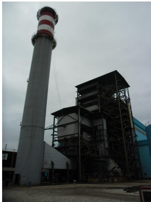
FIGURA 1.1 CENTRAL TÉRMICA TRINITARIA.
