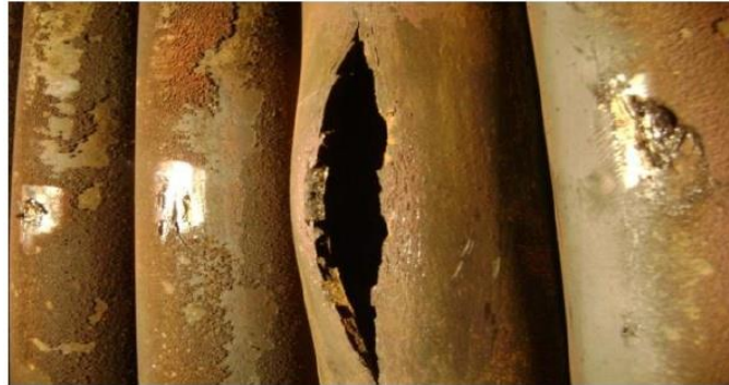
FIGURA 2.14 MECANISMO DE FALLA POR FATIGA TÉRMICA.
