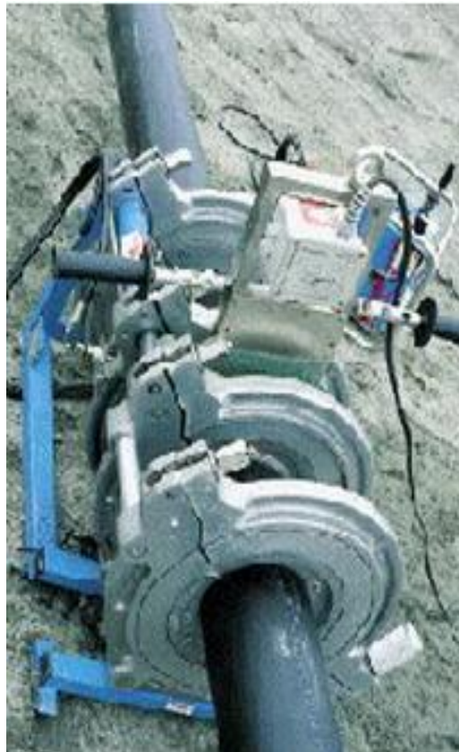
FIGURA 1.3 UNIÓN POR TERMOFUSIÓN. (7)
