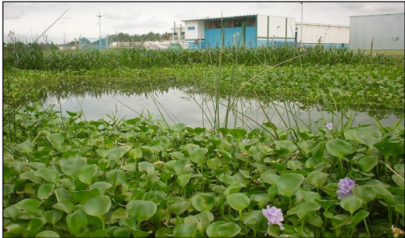
Figura 2.6. Humedal artificial FS en las instalaciones de la empresa Bahco Argentina S. A. (Santo Tomé, Santa Fe).
