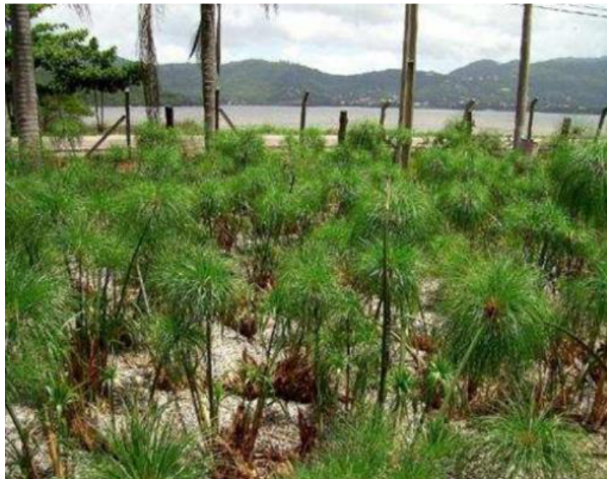
Figura 2.8. Humedal artificial de flujo subsuperficial en un hotel en Florianópolis, Brasil.
