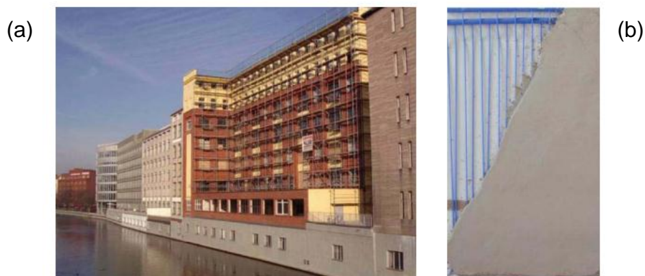
FIGURA 2.5 UTILIZACIÓN DE PCM EN BLOQUES DE OFICINAS EN BERLÍN (A) Y EMPASTADO DE PAREDES SOBRE CAPILARES CON PCM (B) [25]
