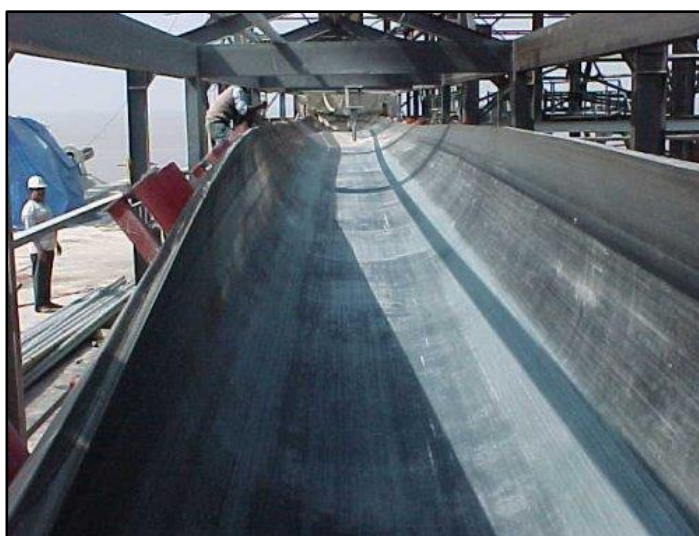
FIGURA 4.1 VISTA SECCIÓN DE CARGA [20]
