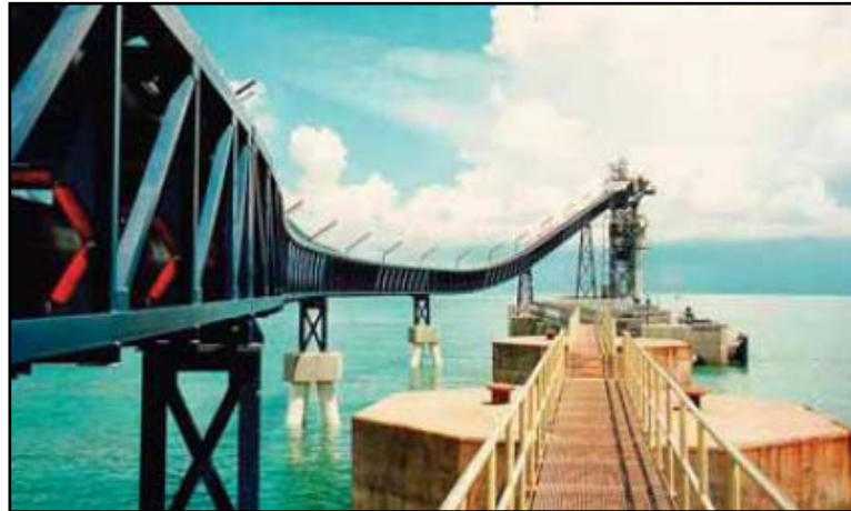
FIGURA 2.2 INSTALACIÓN MALAYAN CEMENT MALASIA [5]
