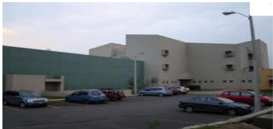
FIGURA 4. 3. VISTA LATERAL EDIFICIO FIEC
