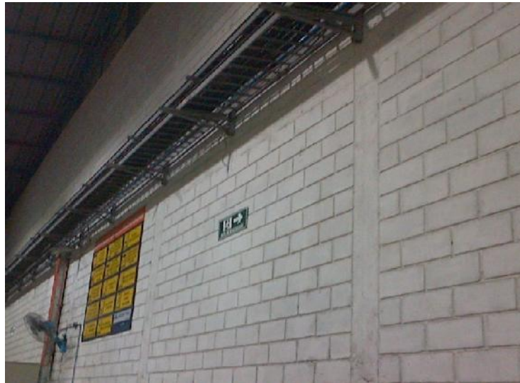
FIG. 4.6 CANALETAS ELÉCTRICAS.
