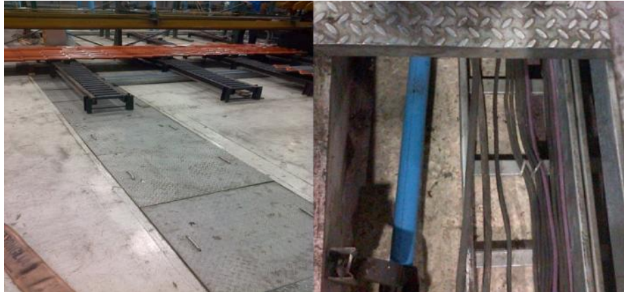
FIG. 4.8 TRINCHERAS PARA EL PASO DE ACOMETIDAS Y TUBERÍAS DE AIRE COMPRIMIDO.
