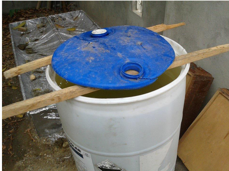
Tanques de reservorio de agua ubicados junto a los humedales
