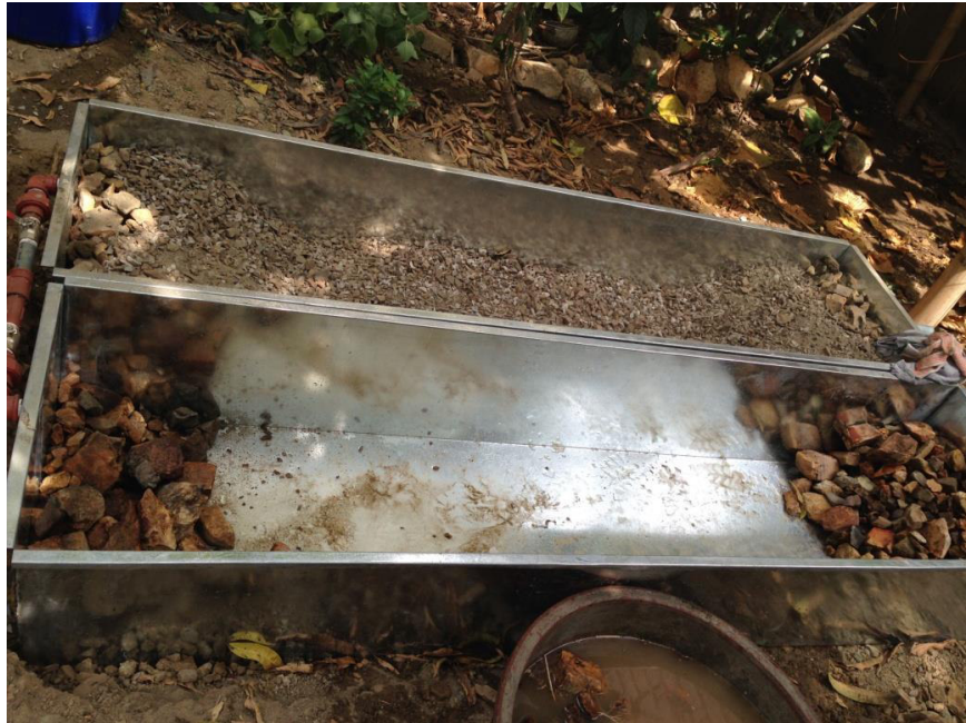
Llenado de los humedales con el material granular
