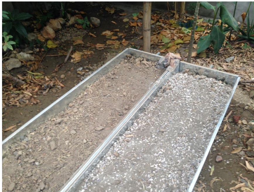
Humedales llenos con el material granular (arena y grava)
