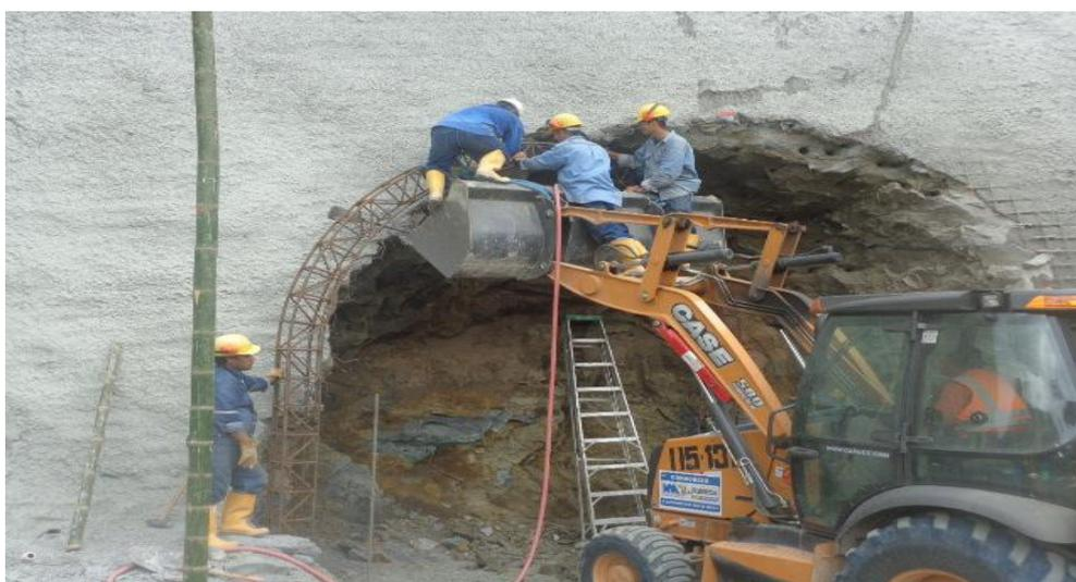
**Fotografía 5.** Excavación y estabilización en el túnel del JOBO 2
