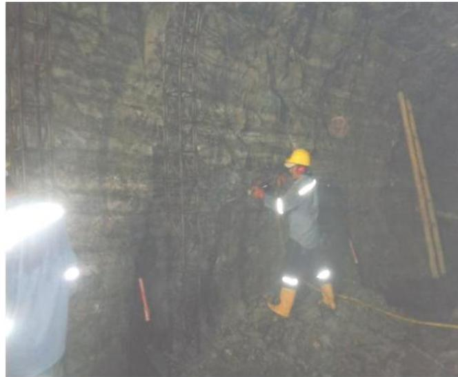
**Fotografía 8.** Excavación y refinamiento de la sección del túnel
