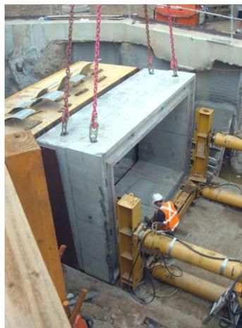
**Fotografía 15.** Túnel de cajón típico
