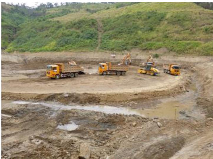
**Fotografía 1.** Construcción de la ataguía de la presa Río Grande
