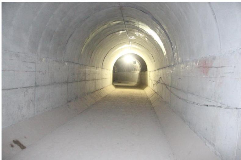
**Fotografía 10.** Soporte secundario desencofrado, etapa constructiva C
