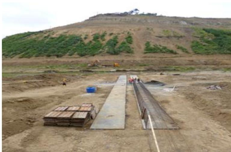
**Fotografía 3.** Pantalla de hormigón plástico de la presa Río Grande
