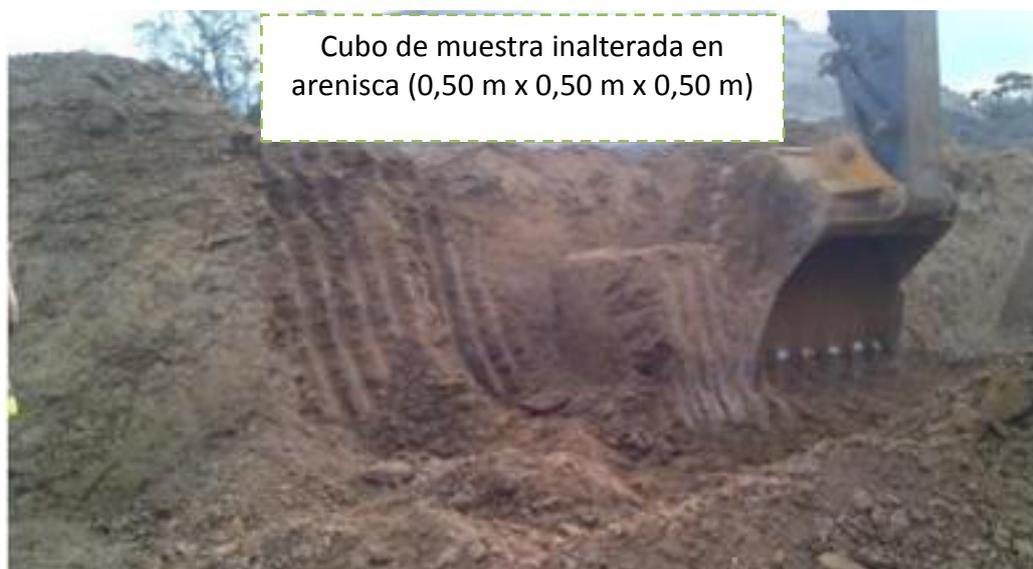
**Fotografía 11.** Extracción de muestras inalteradas en arenisca del JOBO 1
