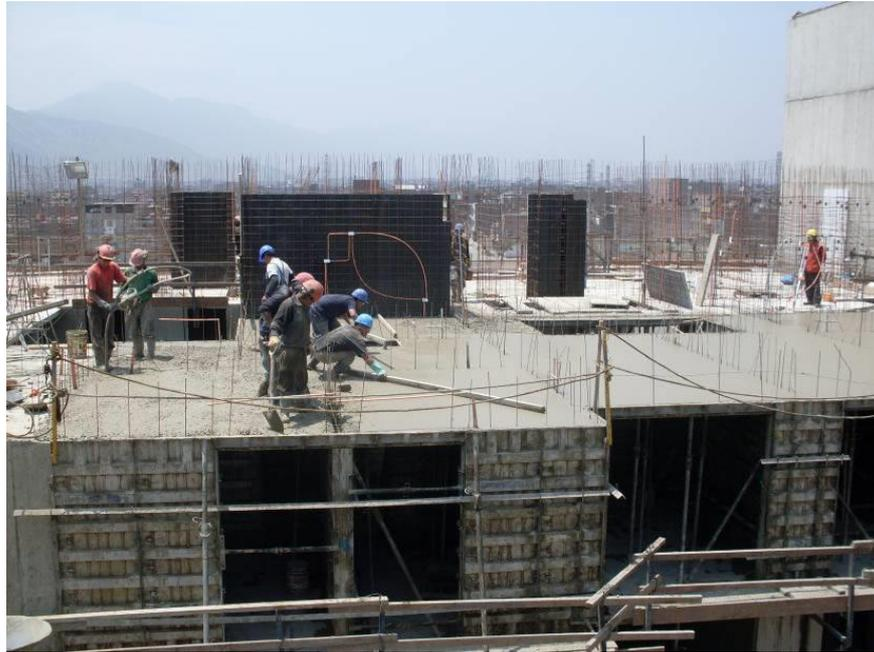
**Figura 4.22 Fundición y Nivelación de losa**
