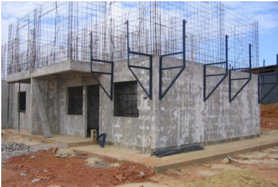
**Figura 4.23 Instalación de Pasarelas para trabajos de niveles superiores**
