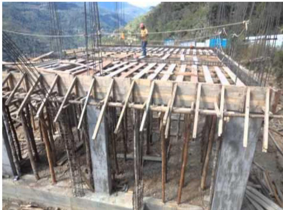
**Figura 4.4** Encofrado de losas y vigas
