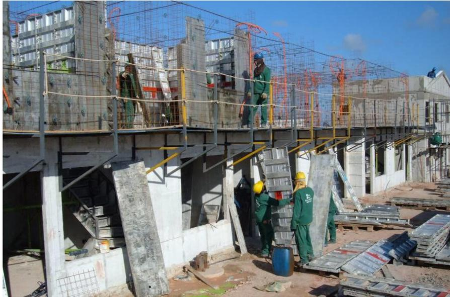
**Figura 4.24 Armado de encofrados con formaletas en nivel superior**
