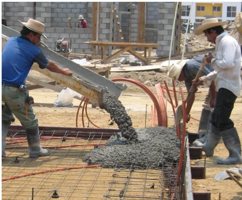
**Figura 4.9 Fundición de cimentaciones**
