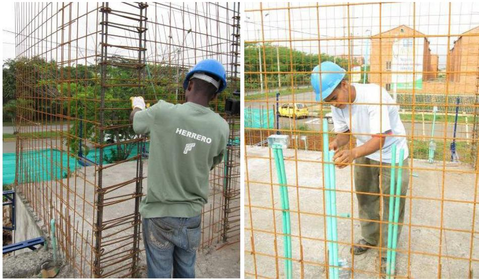
**Figura 4.10 Armado estructural y tuberías PVC en muros**
