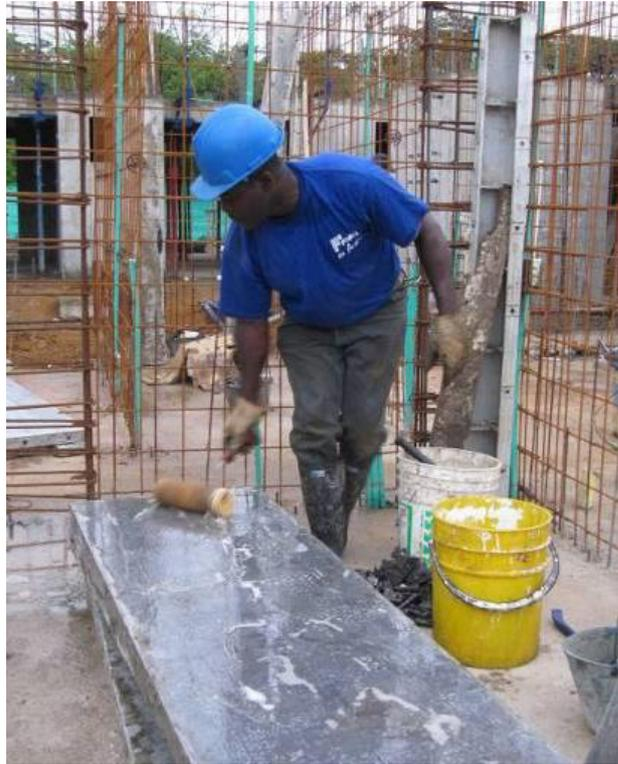
**Figura 4.11 Aplicación de desmoldante en formaletas**
