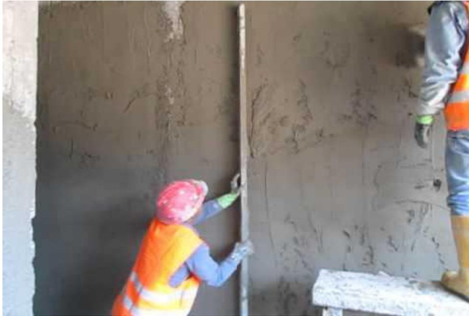
**Figura 4.6** Proceso de Enlucido de Paredes de bloque
