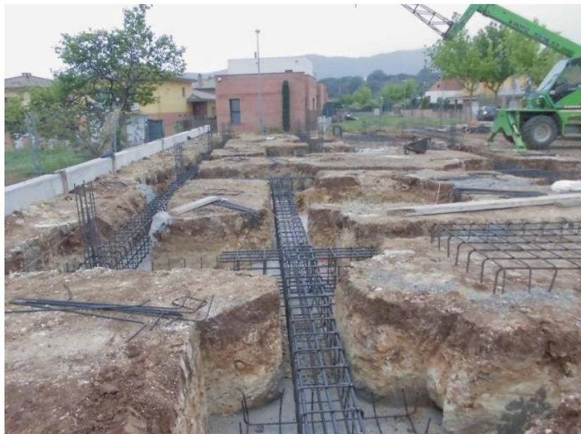
**Figura 4.2** Ejemplo de zapatas corridas para cimentación
