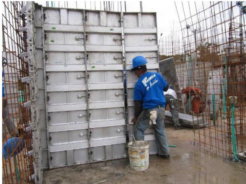
**Figura 4.12 Armado de encofrado con formaletas**
