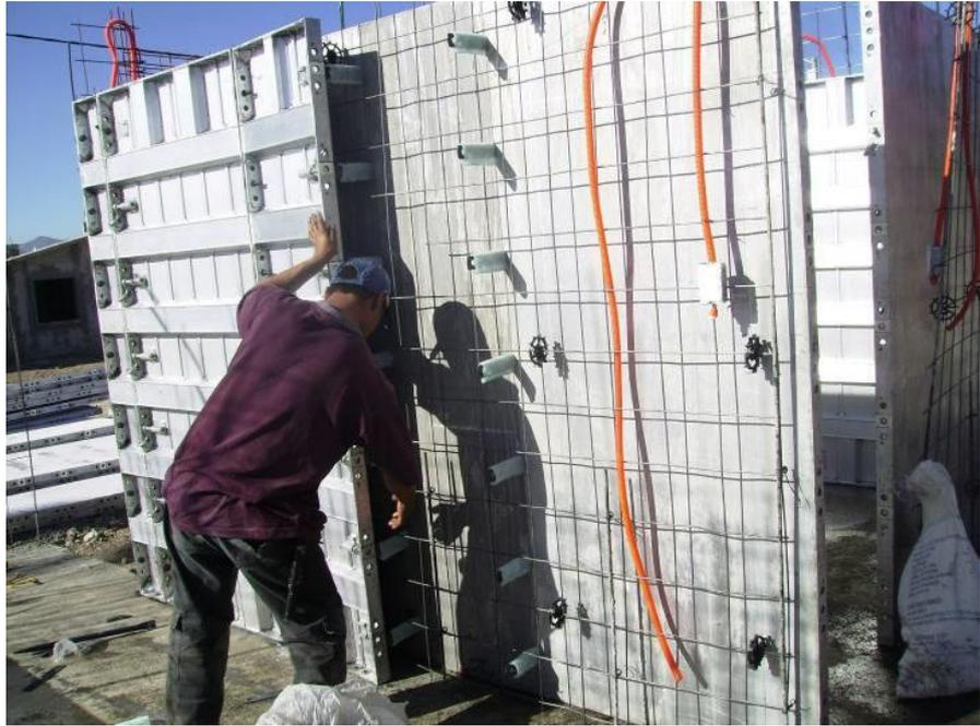
**Figura 4.13 Armado de encofrado con formaletas**
