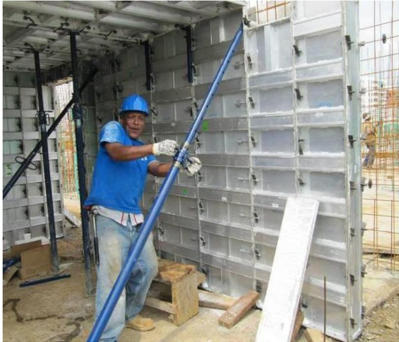
**Figura 4.18 Colocación de tensores de muro**
