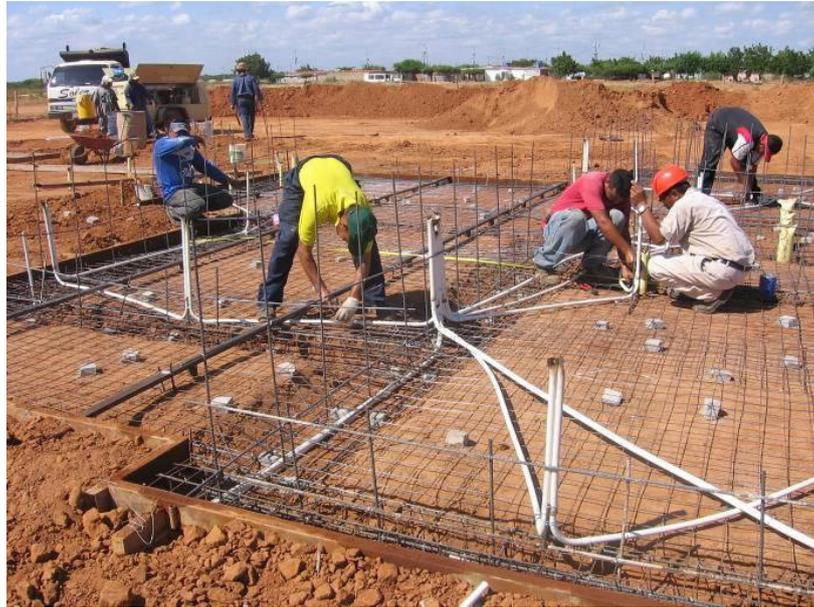
**Figura 4.8 Armado estructural y tuberías PVC en cimentaciones**
