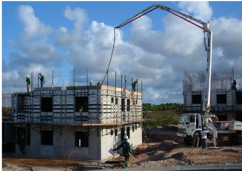
**Figura 4.21 Vaciado de hormigón con pluma**
