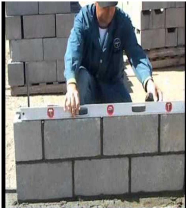
**Figura 4.5** Alzado de Pared de Bloques
