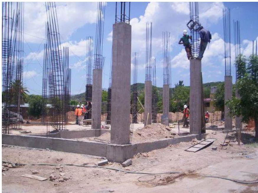
**Figura 4.3** Columnas de Hormigón Armado
