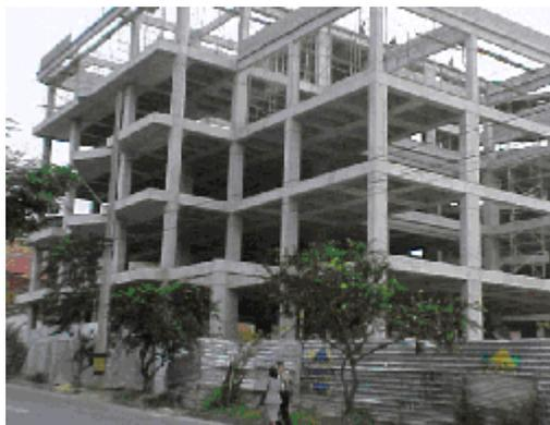
**Figura 4.1** Ejemplo de sistema de pórticos (pórtico)
