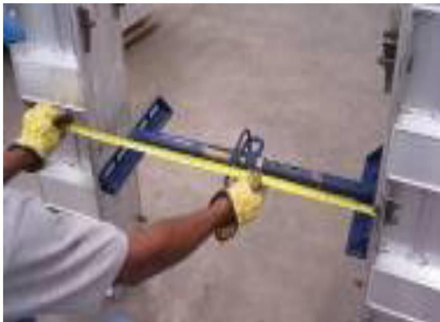
**Figura 4.16 Colocación de Tensores en puertas**
