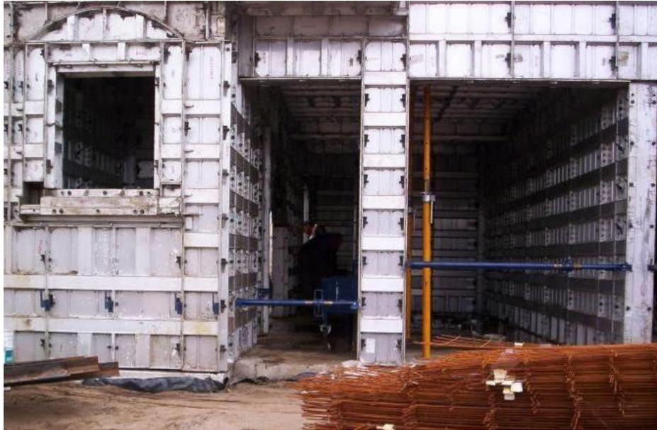
**Figura 4.17 Colocación de Tensores en boquetes de vivienda**
