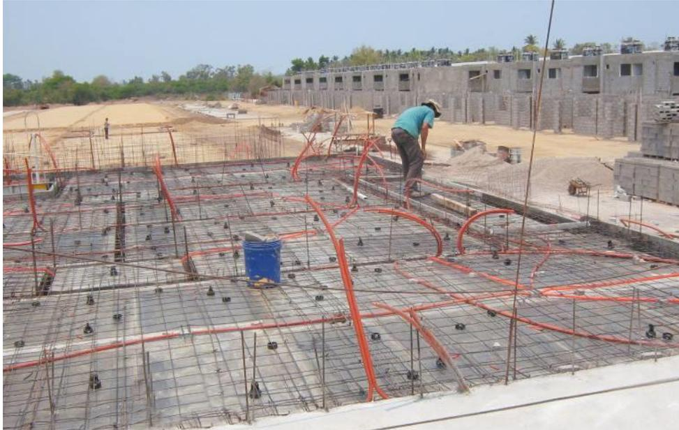
**Figura 4.20 Colocación de malla y tuberías en losa**
